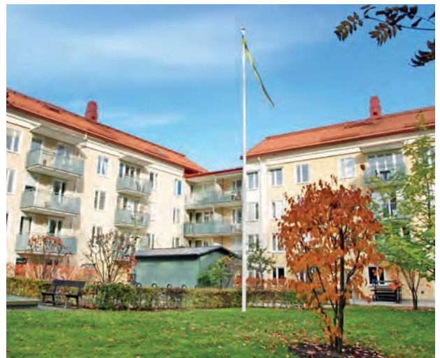
Bullerskydd och den långsträckta byggnadsutformningen dämpar trafikbullret.
