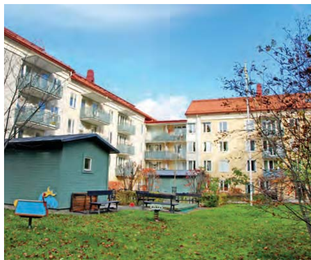
Bullerskydd och den långsträckta byggnadsutformningen dämpar trafikbullret.
