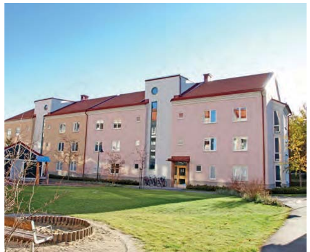
Entréer mot ljus och bullerskyddad gård.
