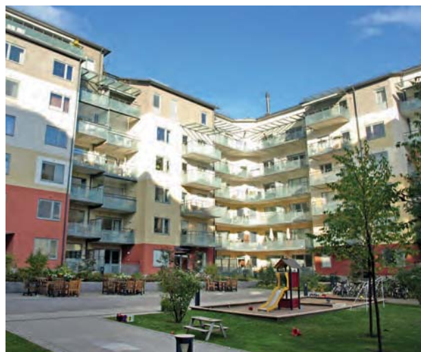
Den relativt slutna byggnadsutformningen medför effektiv avskärmning av bullret från trafiken på gatorna.
