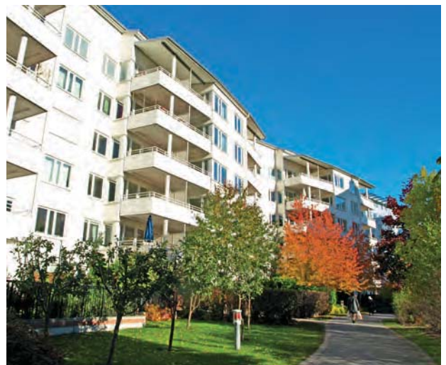
Den långsträckt byggnadsutformningen medför effektiv avskärmning av bullret från den starkt trafikerade Frösundaleden och skyddade fasadsidor och gård finns.
